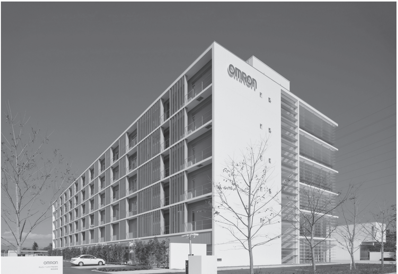
写真-1 南西メカニカルバルコニー側より見る
