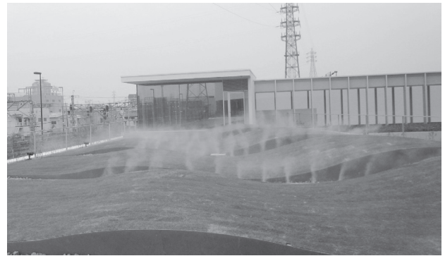
写真-8 2階ルーフガーデンでの噴霧状況
