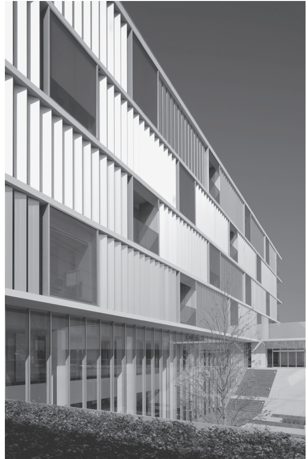
写真-3 建物東側外観
