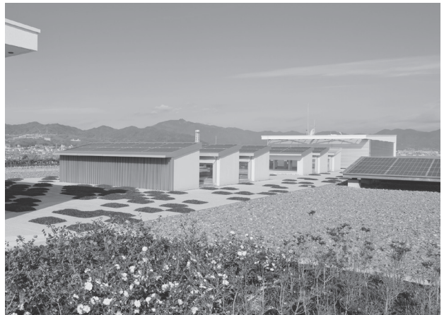
写真-6 太陽光パネル
