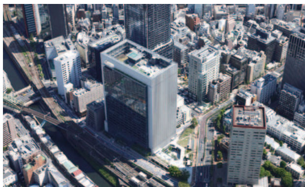
写真-1 建物周辺状況
