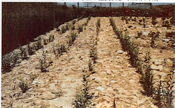
写真11 ヤナギ埋枝工2年目の生長状態 (1984. 7. 16)
