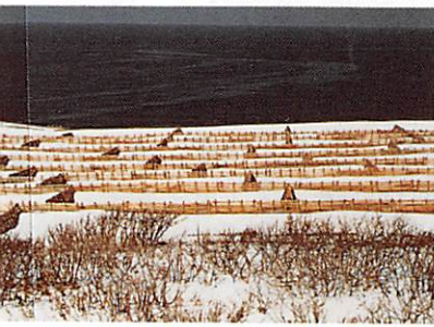
ハードルフェンスの設置状況 (1988. 2. 17)
