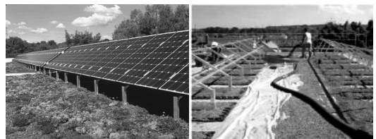
写真-1 ドイツにおける太陽光発電システムと屋上緑化の同所利用の事例(右: Unterensigen 8) , 左: Stuttgart 9) )
