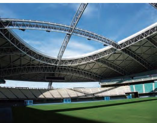
球面状の屋根は、中央に楕円形の可動式の開口部を持つ。開場当初の愛称である「ビックアイ」は上空から見たスタジアムが開口部を含めて目のように見えるのが由来である。屋根外周の固定部は鉄骨構造にチタン板葺、可動部は透光率25%のポリテトラフルオロエチレンコーティングを施したガラス繊維一重膜を使用している。可動部の開閉は、可動屋根の端に取り付けられたワイヤロープを、アーチトラス部分に固定した滑車を介し、地下に設けられたウィンチで巻き取ることにより行っている。開動作及び閉動作に係る時間は各々約20分。
