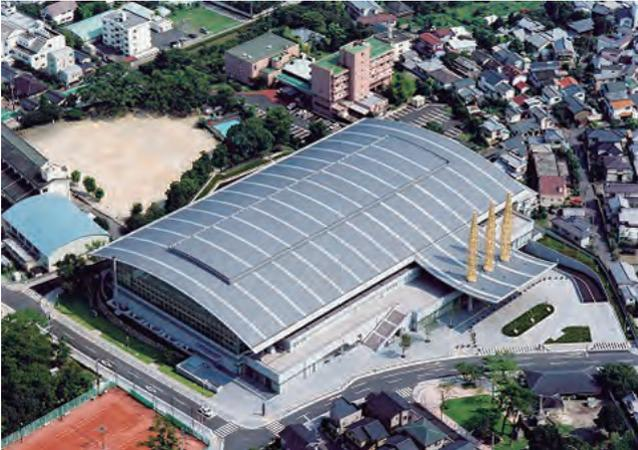
外観計画のメインである緩やかなカーブを描く大屋根とそれに連続する大庇は、別府湾の軽やかな風と波をイメージしているという。また、バンブータワーと名付けられた大庇を支吊する鋼管を組み合わせた3本の鉄塔は、別府の伝統工芸である「竹細工」がイメージされている。これにより、十分なエントランス前空間を形成している。大屋根はH形鋼とタイロッドによる張弦梁架構をバックステイで両端を緊張する構造とし、アリーナ空間と外観に軽快な表情を与えている。
