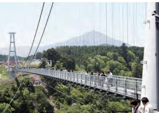
2006年10月30日に開通。高さ173m(水面より)、長さ390mで、歩行者専用橋としては日本一の高さで長さ(長さに関しては2015年12月に、静岡県三島市で建設中のつり橋が日本一となる予定)である。幅員は1.5mで、大人1,800人の荷重に耐えるように設計されている。中央部の床版は、耐風安全性を考慮した「すのこ状」のグレーチング床版になっていて、下を見ることができる。ねじれ振動(フラッター)対策にさらに「フェアリング」を採用している。歩行者によって誘起される振動を抑
