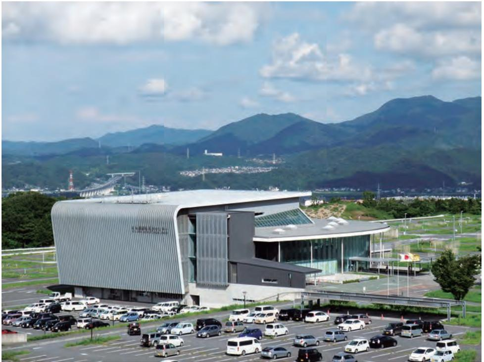
当建築は、居室部分を集約してまとめたキューブ状のボリュームを、円形のワンルーム型ロビーが囲むシンプルな構成である。居室が集約されることで構造的にも地震力を負担するコアとなっている。ロビー空間においては、全体を LSL 板と鋼板の格子梁による大屋根で覆い、水平力をキューブへ伝達する構造とすることで、柱を軸力のみを負担する  $\phi=190.7\text{mm}$  の小径なシームレス鋼管にすることが可能となった。結果、空間の開放性と自由度を高めている。格子梁は  $1.8\text{m} \times 1.8\text{m}$  のグリッドであり、基本部分では2枚の鋼板をBOX状に加工し、応力の大きな部分や梁交差部ではBOX状の梁と同形状に加工して組み合わせ構成されている。（前田静華）
