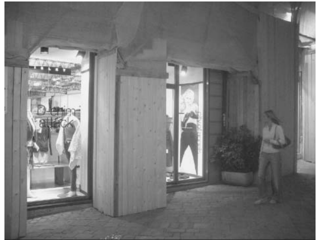
写真2 都心部における修復工事中の建物 マルケ州の中堅都市マチェラータ (Macerata) 都心部にて。建物は工事中であるが一階のブティックは平常通り営業している。
