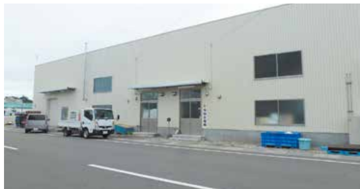
▲新浜町・仮設工場
