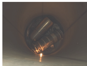
図6 崩壊した筑波大学の12UDペレトロン加速器
