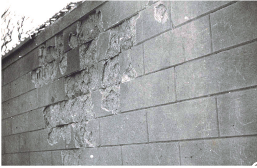
写真4 ニコライ堂下土留壁
