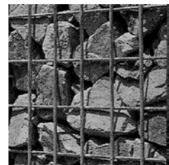
写真1 小口積み溶接金網
