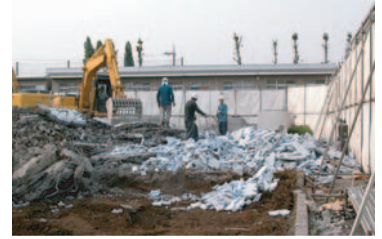
武蔵小金井の解体現場 三人の作業員がコンクリートのかけらから手で発泡スチロールをはがしている。
