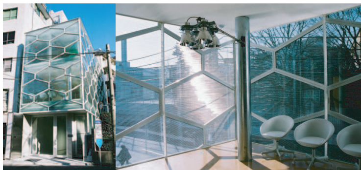
トランスビル 施工:辰
