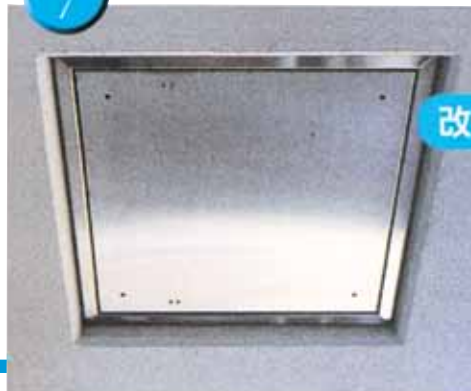
7 新設ハッチした蓋、下枠
