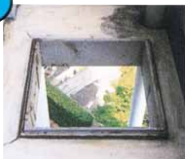
6 はしごを取り付け上枠周囲に 防水コーキング
