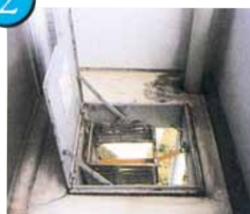
5 新設枠、上枠下枠を取り付ける
