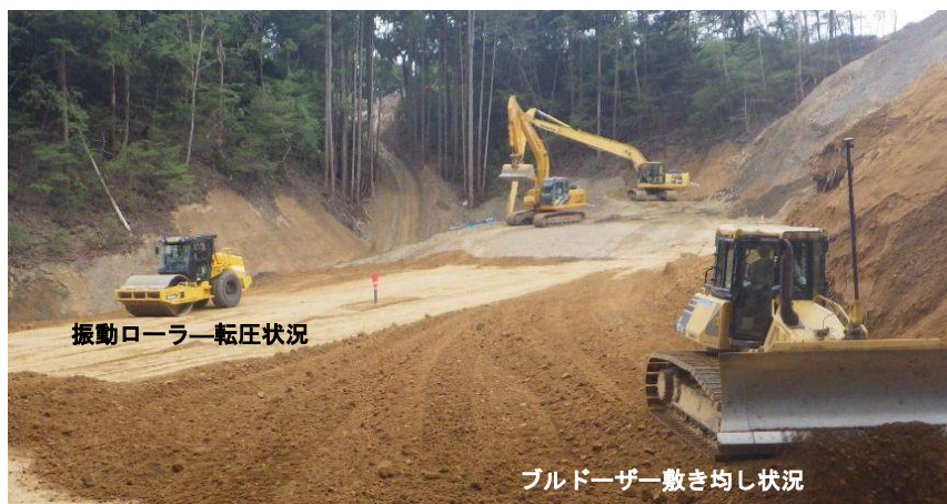
図8 盛土敷き均し転圧状況
