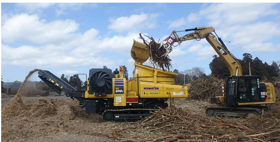
図6 伐採材粉碎状況
