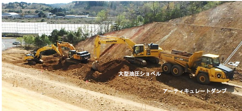
図7 掘削運搬状況
