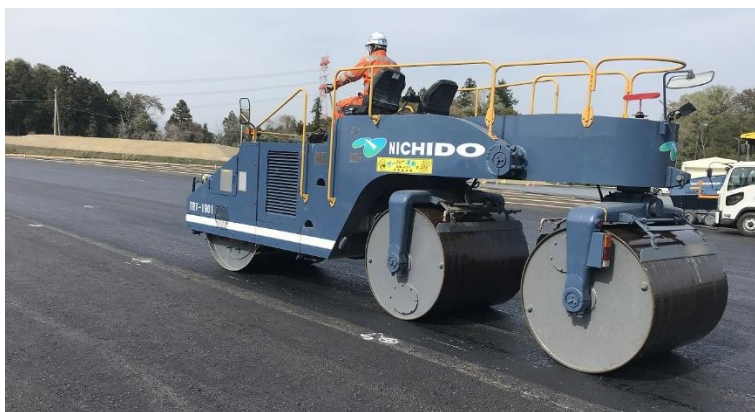
図12 3軸ローラ転圧状況
