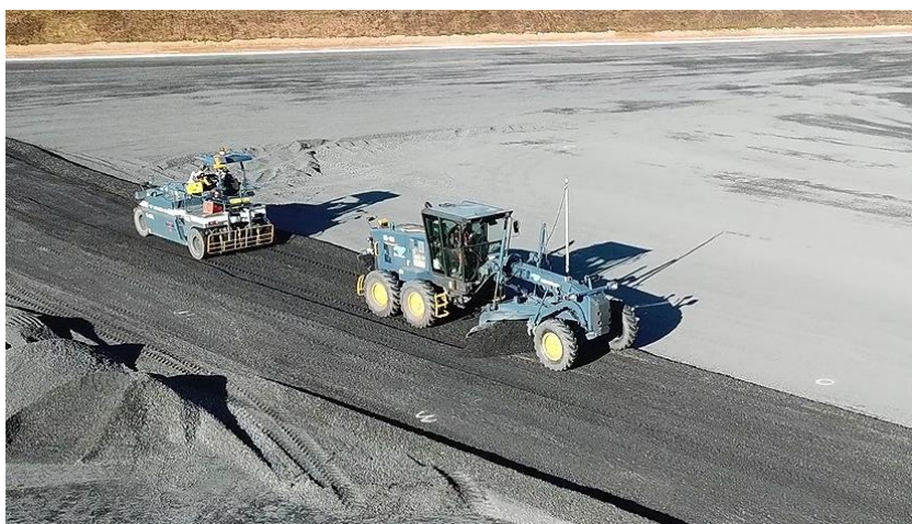
図10 砕石路盤整正状況
