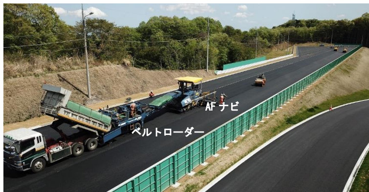
図11 アスファルト舗設状況
