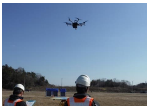
図2 UAV測量状況
