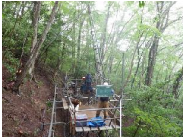
図4 ボーリング調査状況
