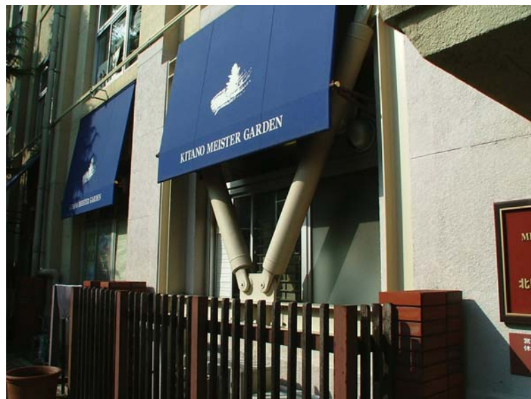
図 3-7 耐震補強のために設けられた鉄骨ブレース（旧北野小学校、現北野工房のまち） （2006年6月著者撮影）
