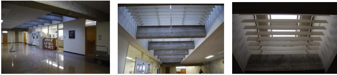
3階廊下部天井の様子（左、中央）と3階廊下天窓（右）
