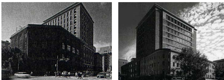
用途変更前東側外観（左）と用途変更後北側外観（右）
