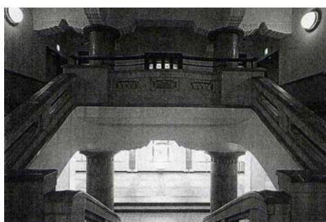
旧 38 条適用により堅穴防火区画が免除された中央階段（左）と 4 階から見下ろしたアトリウム（右）
