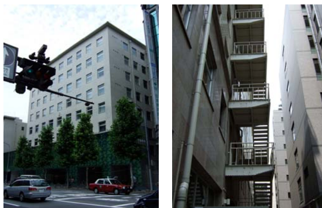
正面外観 (左) と増設された屋外避難階段 (右)
