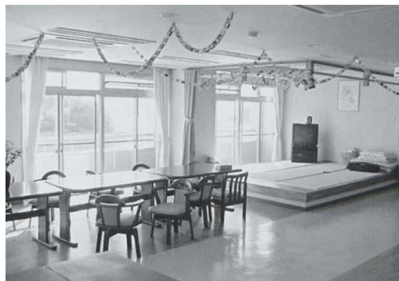
改修後の食堂と上部排煙窓
