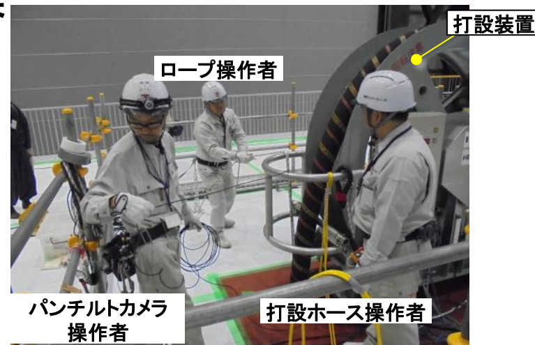
作業フロア作業状況
