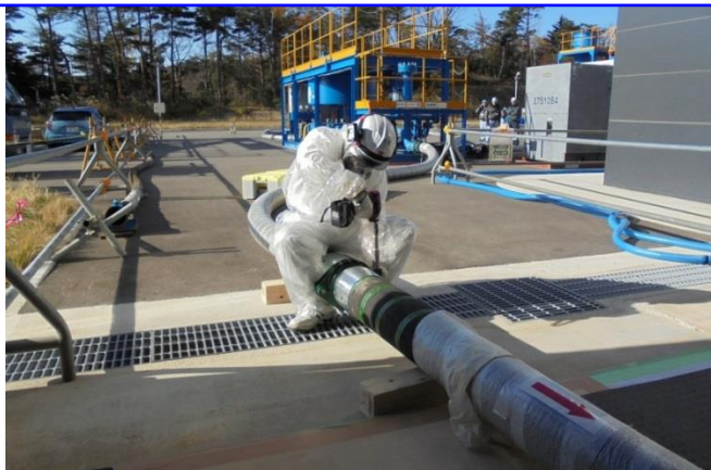
防護装備着用でのホース交換作業
