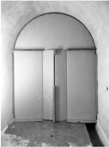
写真一〇 紙素材のダム風の監視廊用扉の設置状況
