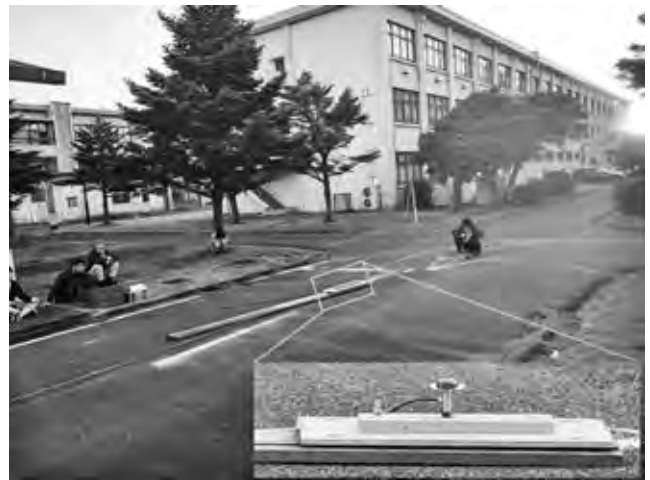
写真-2 スライドレールの設置状況
