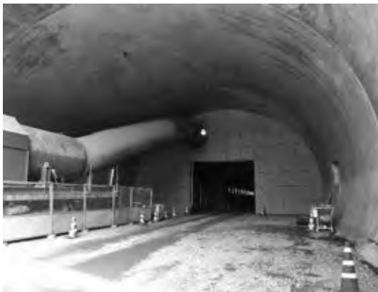
写真-15 紙素材の風門の設置完了状況
