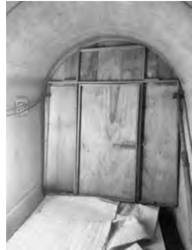
写真一七 木製のダムの監査廊用扉の例
