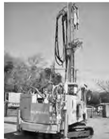
写真-2 小型施工機設置状況
