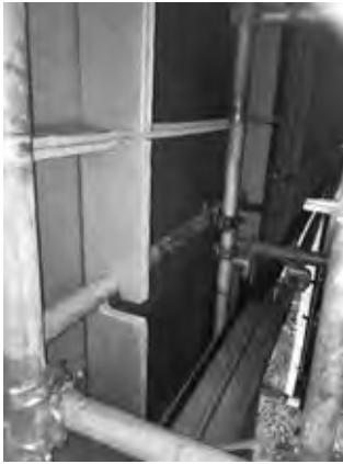
写真-13 切り欠きによる支保工への固定状況
