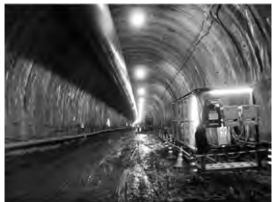
写真-4 耐候性試験を実施したトンネル内の状況
