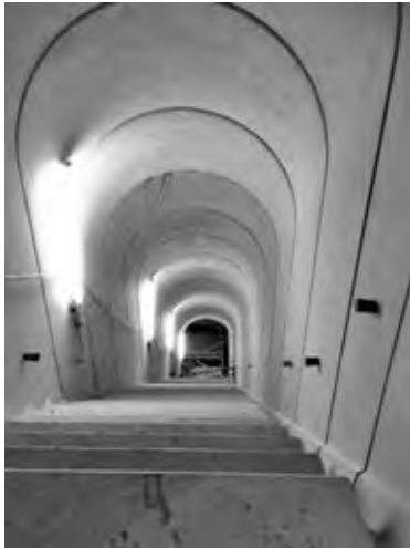
写真一五 ダムの監査廊の例
