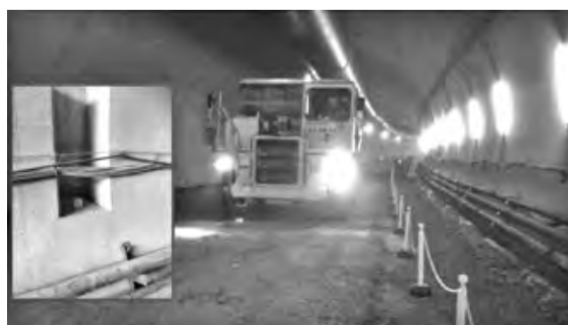
写真—1 実証実験のトンネル坑内と設置したビーコン
