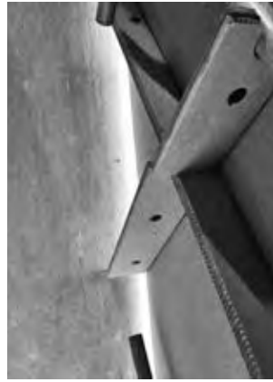
写真-14 紙素材用ネジによる部材同士の接合
