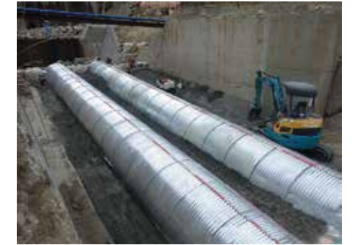
災害復旧時の応急排水路での設置状況
