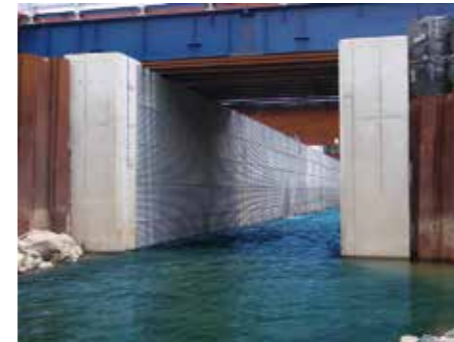
仮排水路での使用例-1
