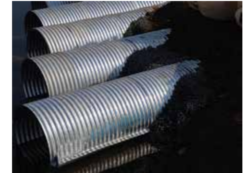
仮設工用道路の排水路での設置状況
