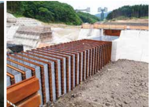
仮排水路での使用例-3
