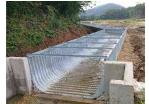
排水路での使用例
