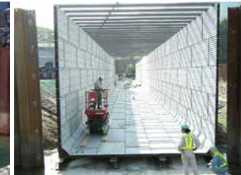
仮排水路での使用例-2
