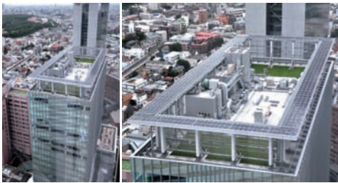
東日本旅客鉄道株式会社様・JR南新宿ビル(東京都渋谷区) *設置モジュールはNQ-134LW、耐風圧荷重5,400Pa。
