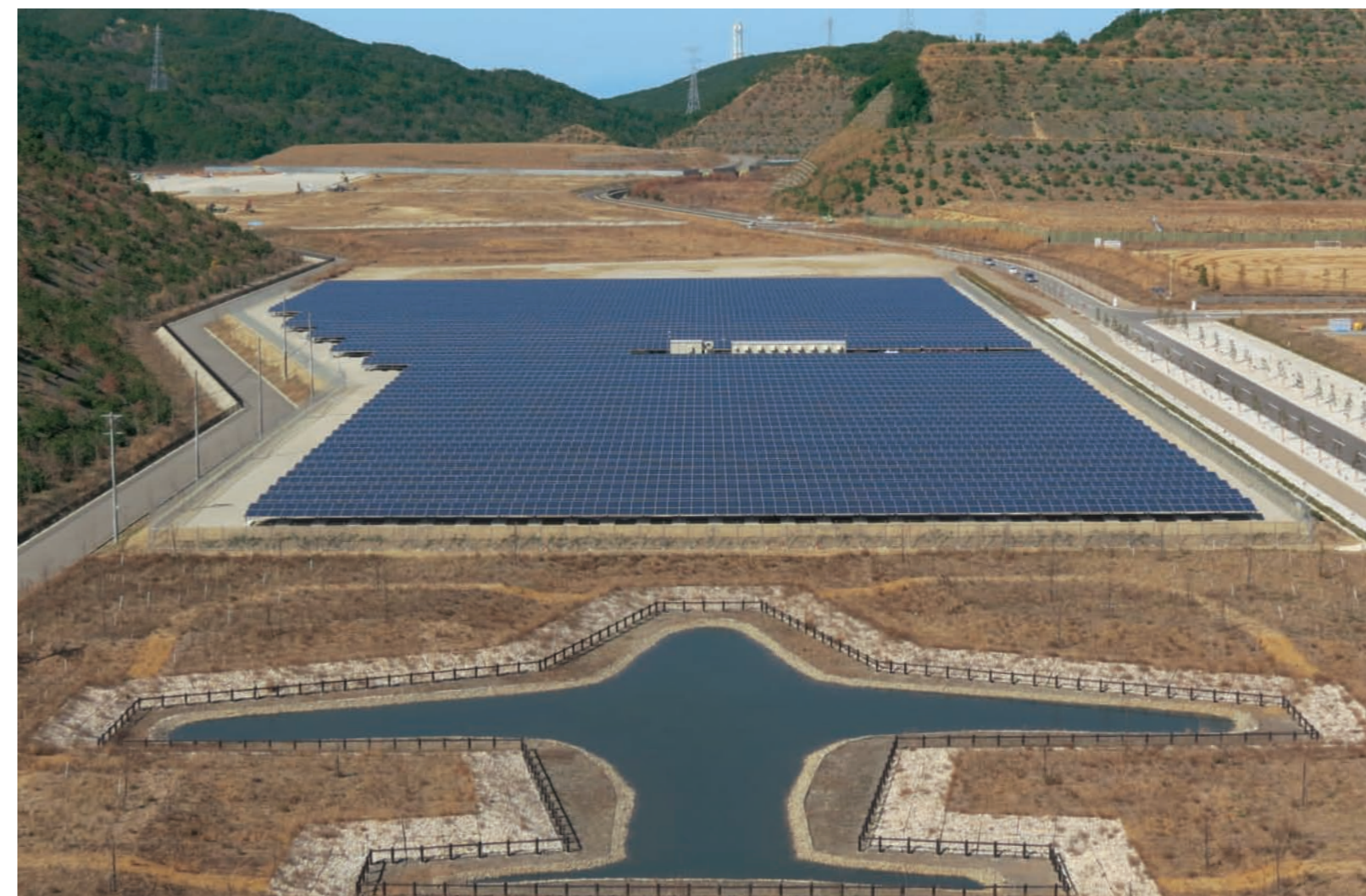
シャープ多奈川太陽光発電所(大阪府泉南郡岬町) 多奈川地区多目的公園に設置。関西国際空港二期事業の土砂採供給工事の跡地を活用。
