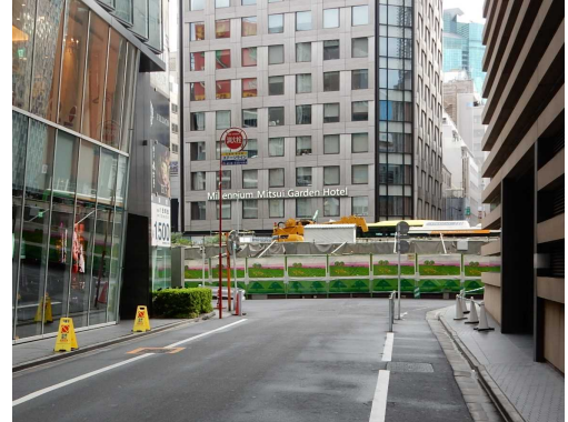
「三原橋地下街」工事現場(手前が堀跡)
