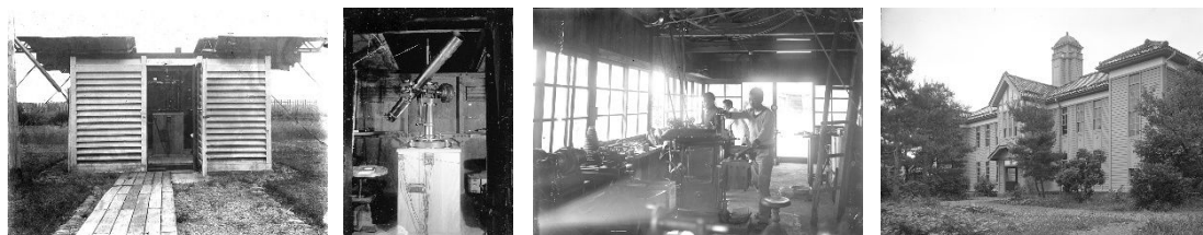
写真1 ガラス乾板から復元した建物写真。初代眼視天頂儀室外観、同内観、職工場内観、第2代本館外観
