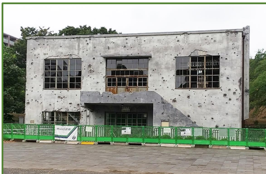
2度目の修復工事が完了した旧日立航空機立川工場変電所（2021年8月撮影）
