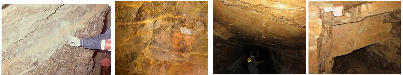
断層粘土（入口に続く大きな断層） 逆断層
