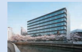
ヤマタネビル新館
