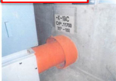
⑥電気配線貫通部
