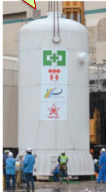
フィルタベント設備
