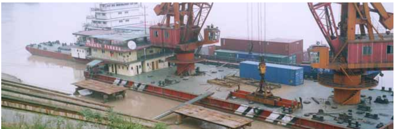
図表 - 257 九龍坡コンテナターミナルの荷役状況
