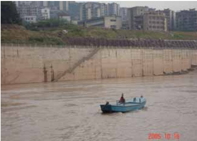
図表 - 254 水位差対策で水面下まで降りている階段
