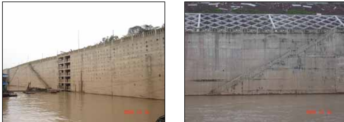
図表 III-268 重慶付近の堤防が語る水位差の痕跡
