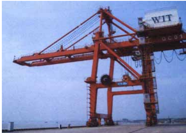
図表 - 246 陽邏港コンテナターミナルのガントリークレーン
