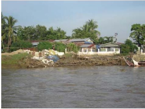
Twante 地区堤防被害 1 (東側)
