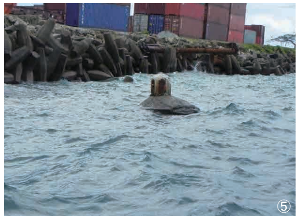
係留柱の状況
