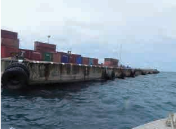
国際埠頭岸壁の状況
