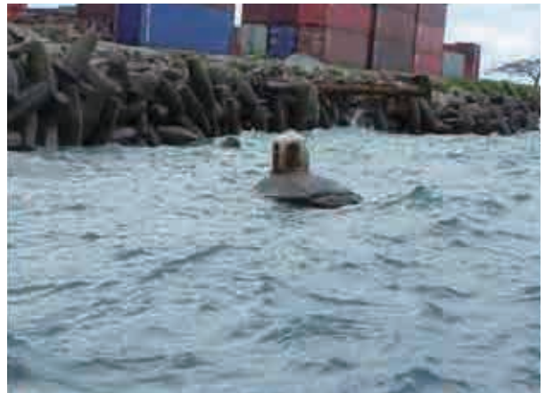
係留柱の状況
