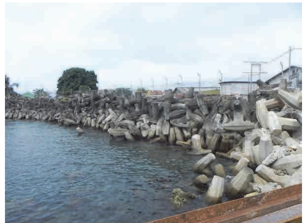
Kabui 棧橋の北側の護岸工
