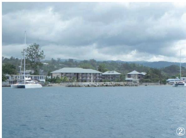
ヨットクラブの防波堤の状況
