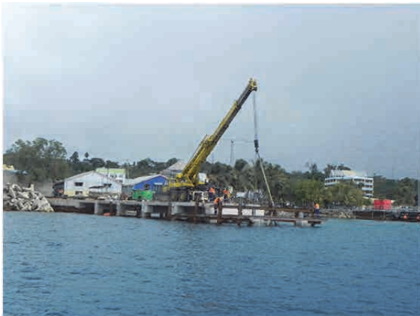
Kabui 棧橋の建設状況
