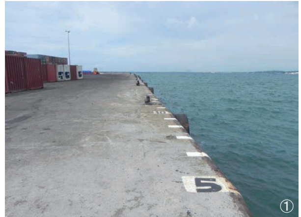
岸壁施設の状況
