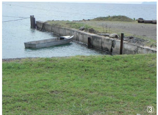
埋立地端部の護岸の状況
