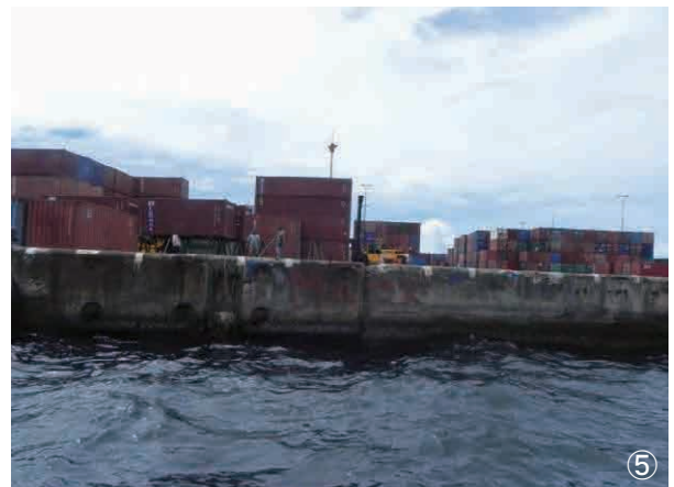
新旧岸壁の接続部
