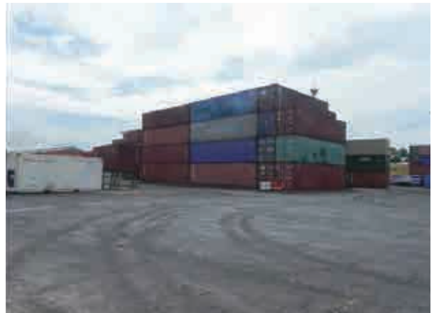
コンテナヤードの状況
