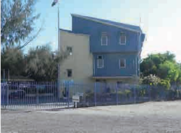
港長事務所棟の状況
