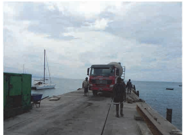
Kabui 棧橋の建設状況
