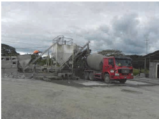
写真 6 - 3 コンクリートプラント
