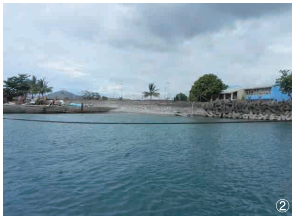
埋立地と護岸工の状況
