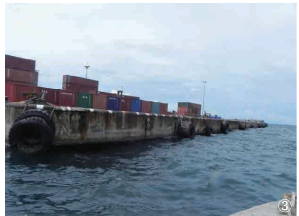
岸壁前面の状況
