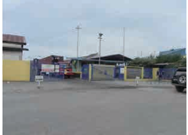
港湾ゲート（出口）の状況
