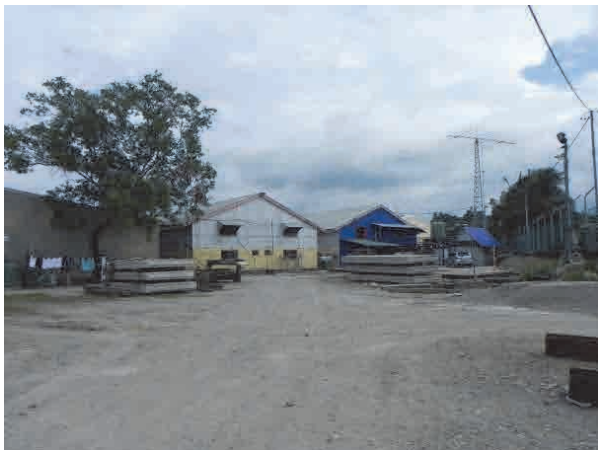
Kabui 棧橋背後の作業ヤード
