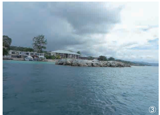
ヨットクラブの防波堤の状況
