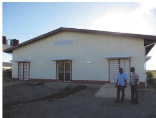
竣工後 東側より撮影 2015年7月2日
