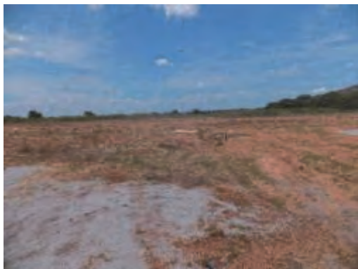
工事着工前の状況 東側より撮影 2013年12月2日
