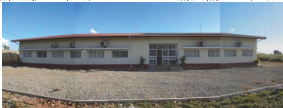
竣工後 北側より撮影 2015年7月2日
