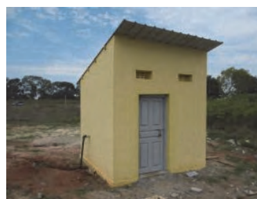
完成したポンプ小屋
