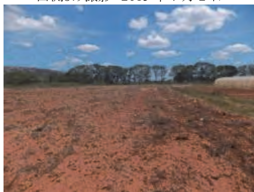
工事着工前の状況 南側より撮影 2013年12月2日
