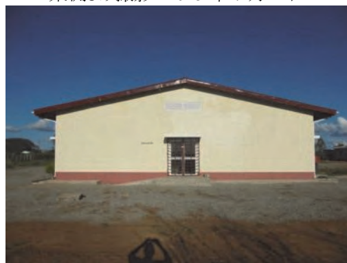
竣工後 西側より撮影 2015年7月2日
