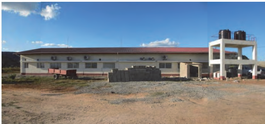
竣工後 南側より撮影 2015年7月2日
