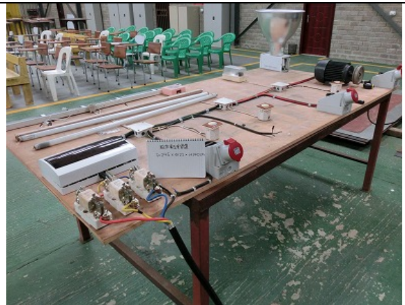
写真-16： ナカラ CFP・電気工事コース 共通 Workshop 内配置の自作配電実習盤
