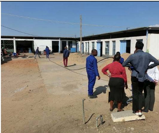
写真-5: マシャバ CFP・配管コース 埋設作業実習の状況
