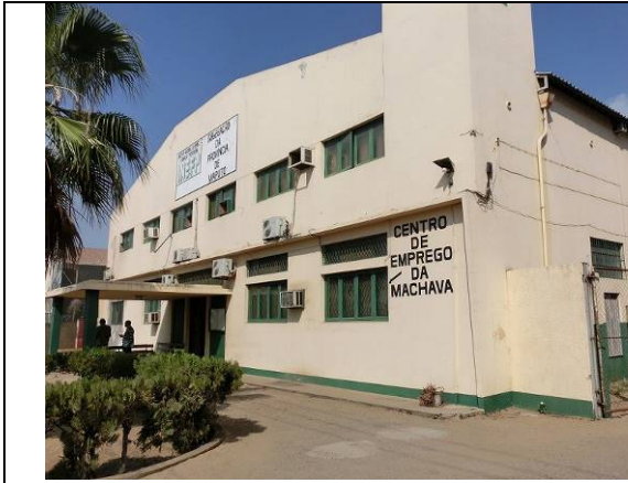
写真-1: マシャバ CFP・エントランスからの外観
