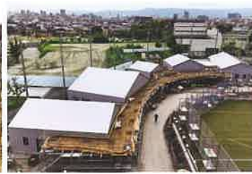
特別教室棟・渡り廊下施工状況
