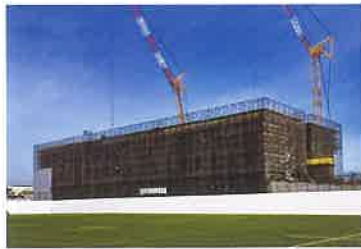
校舎棟建方時施工状況
