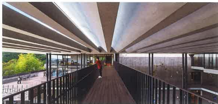
プレキャストコンクリートとハイサイドライトにより自然光を採り込む大屋根
