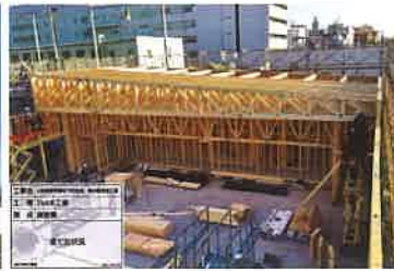
特別教室棟木トラス施工状況
