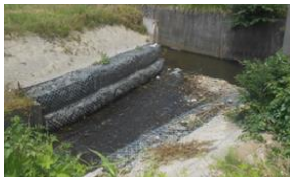
1. 農業生産基盤整備 用排水路施設整備 平田地区他排水路修繕業務委託工事
