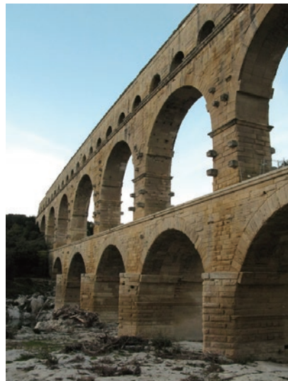
▼ガール水道橋
