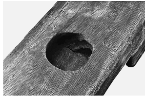
図8 92桁材下面の丸ホゾ穴
