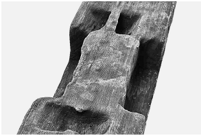
図7 92桁材上面の渡脛仕口
