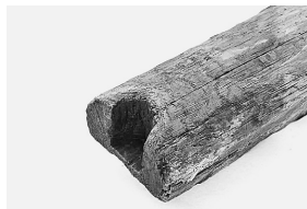
図14 91桁材下面の丸ホゾ穴
