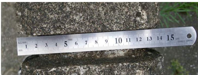
図 6-1 壁の厚み確認
