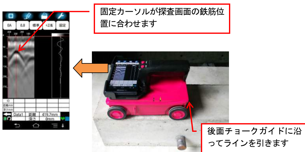
図 6-6 前進探査墨だし
