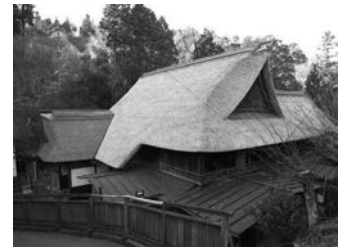
葺き替えが完了した屋根
