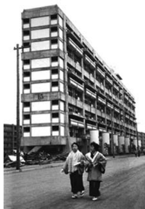
解体前の晴海高層アパート
