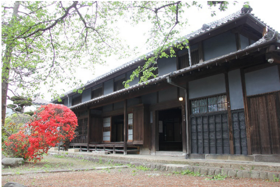
「旧ヤマジユウ田村家主屋」外観
