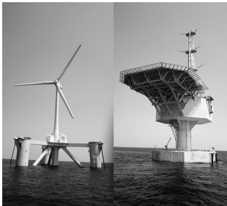
図 5 2MWダウンウインド型浮体式洋上風力発電設備「ふくしま未来」(左) 浮体式洋上サブステーション「ふくしま絆」(右)
