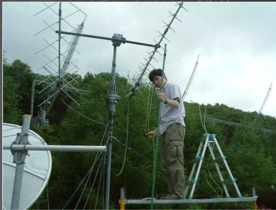
菅平局アンテナの補修風景
