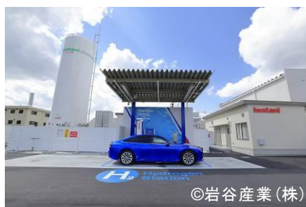
水素ステーション(姫路市)
