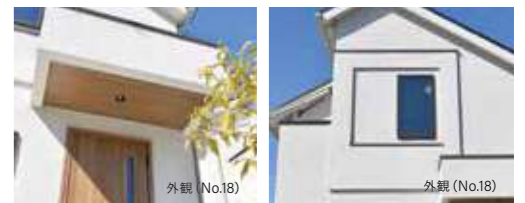
(左) 玄関の底および裏側の仕上げはぬくもりある「木彫シート」を採用。(右) シンプルな外観であるがゆえに街並みが単調にならない工夫が必要。窓まわりを中心に、棟ごとに変化をつけた「ふかし壁」とすることで一邸一邸の表情を創り出しています。
