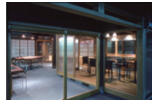
▲ 置り上げ戸のあった入口には、大きな透明ガラスの扉を設置して、音・熱環境を確保しつつ、「通り」と内部空間との連続性を持たせた。
