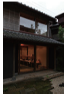
裏側の外観、軒下も再生した。
