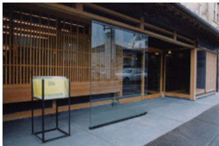
▲ 軒下空間には、不動産チラシ入れ、ガラススクリーン（現代の暖簾）、アクリル製の袖看板をデザインし、通行く人とのコミュニケーション空間とした。
