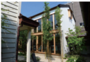
小屋組以外、全て新しくする。改修完成。
