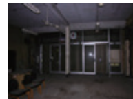
旧西の宮 母屋店舗改修前内観
