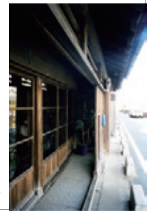
↑しゅはり: 強化ガラスで軒下空間を作った。 参考: 置き敷居+格子の伝統的な軒下空間。→
