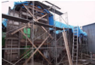
洋館を足屋して土蔵から離す。
