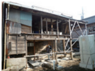
増築部が撤去された直後の倉庫側面。
