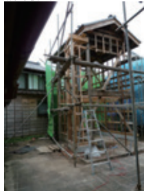
基礎、骨組みを新しくする。
