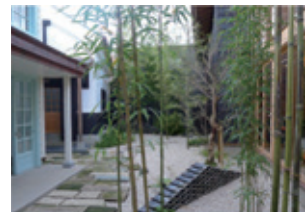
庭の基礎石を敷き、植栽を植える。
