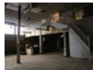
改修前の内観
