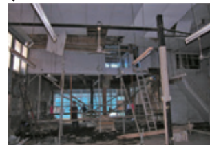
増築部、倉庫を解体する。
