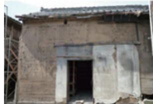
増築部分を撤去した後の土蔵。
