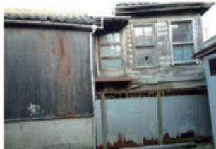
洋館とつながる土蔵。裏側から見たところ。
