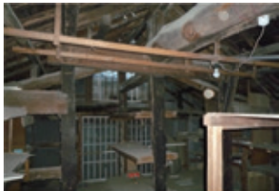
土蔵内部は、暗闇で埃にまみれていた。
