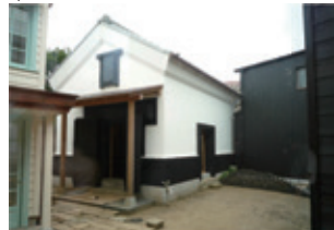
しっくりの補修、屋根吹き替え、下屋底をつけ、漆喰戻修復。
