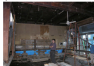
かさ上げされていた階高を下げる。
