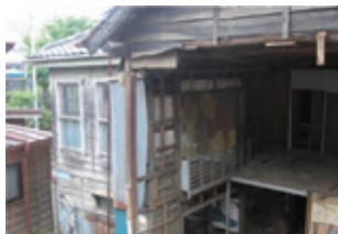
母屋と洋館の間を切り離した後。
