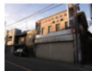
改修前の外観
