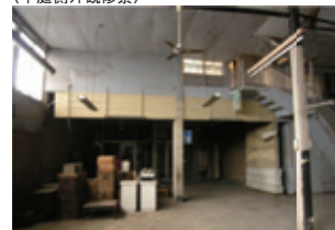
西の宮 改装前母屋を中庭側から見る。
