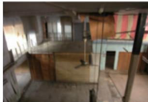
洋館、蔵、倉庫が一体となった巨大な内部空間。
