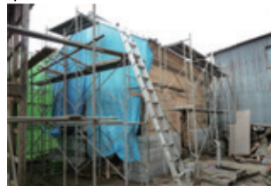
ジャッキアップして基礎を新設。
