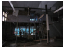
改修中の内観。増改築の結果、中庭はなくなり裏側の軒も切られていた。
