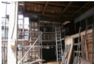
増築部を壊しながら洋館を切り離してゆく。
