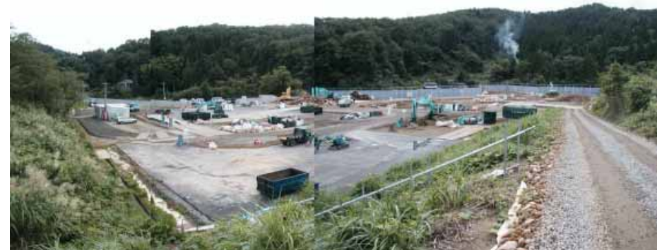
写真 刈羽村家屋解体廃棄物仮置き場全景
