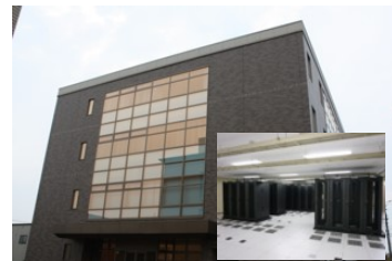
ITビジネスセンター（DC、ビジネス拠点）
