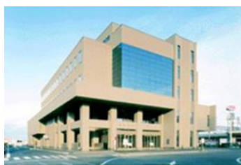
自治体ネットワークセンター（拠点施設）
