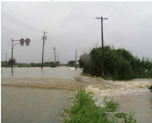
平成 15 年 8 月 (豊川市三上町で県道を洗い洪水が堤内地へ浸水)
