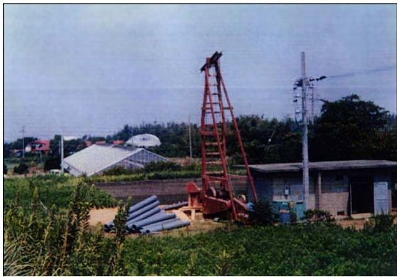
渇水時の応急井戸掘りの様子（平成6年渇水時）
