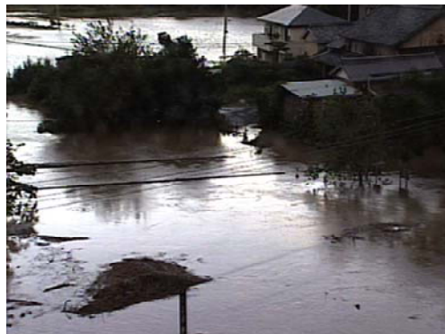
平成 23 年 9 月 (豊橋市下条地区の浸水被害)
