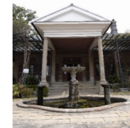
▲旧オルト住宅(正面ポーチ) 56
