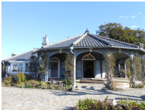
▲旧グラバー住宅主屋
