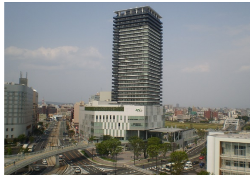
整備後(平成24年)
