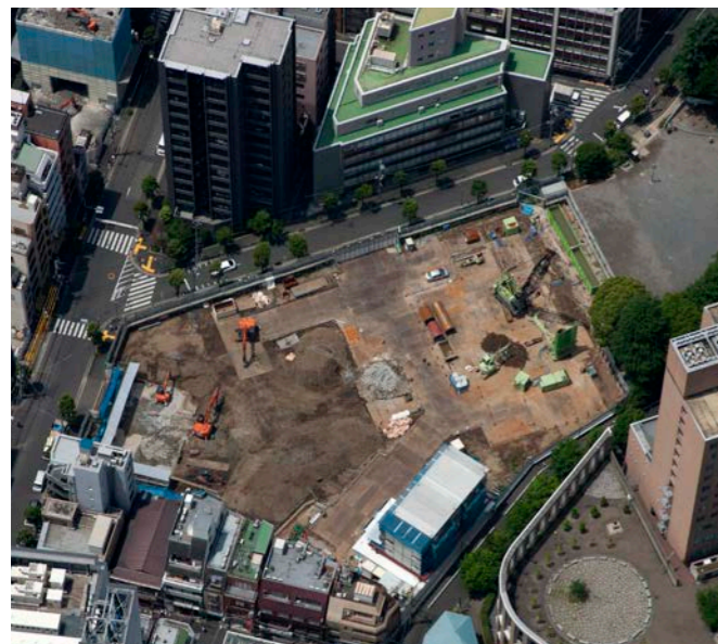
2021年5月 旧錦華小地下躯体解体
