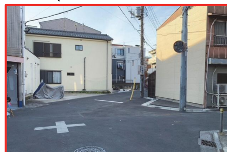
10号線(拡幅整備後)
