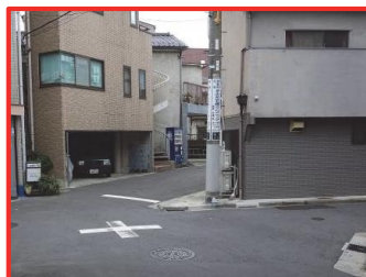
⑤ 10号線(拡幅整備前)
