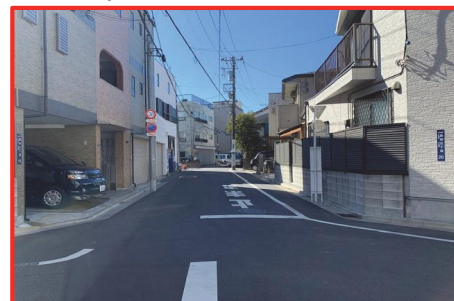
1号線(拡幅整備後)
