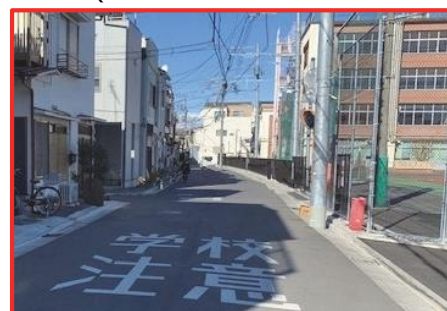
9号線(拡幅整備後)
