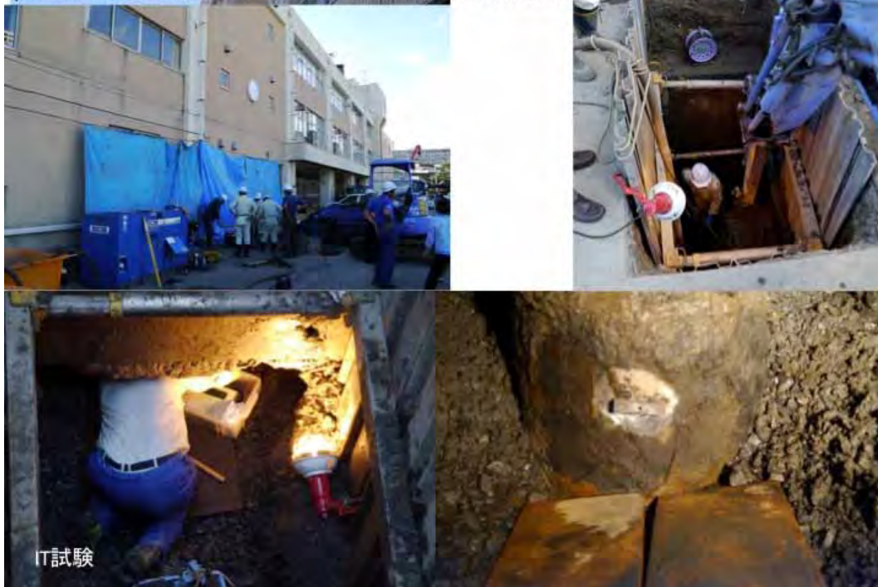
図 1.4.1-3 杭の健全性調査 1
