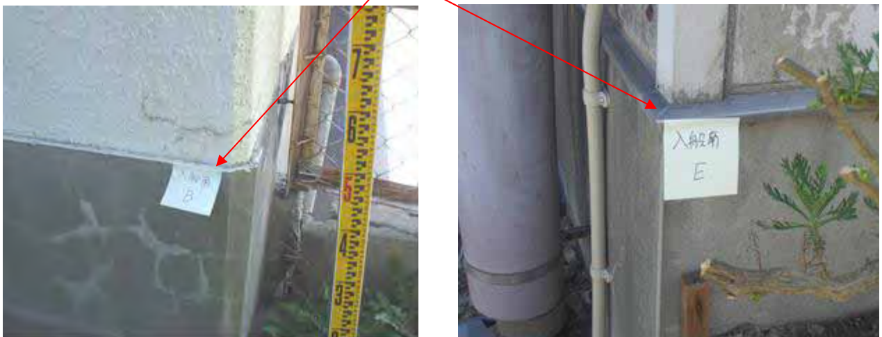
写真-1.3 水準測定点とした基礎梁天端（水切り天端）の例
