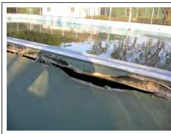
入船中学校 プールサイド
