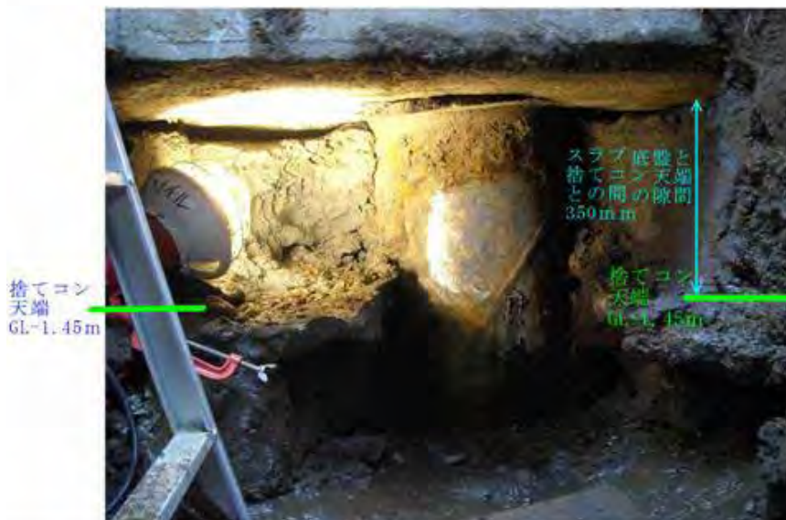
図-2.2.2 杭側面の掘削状況・杭頭部の状況（高洲小学校）
