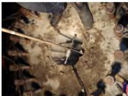
傾斜測定状況
