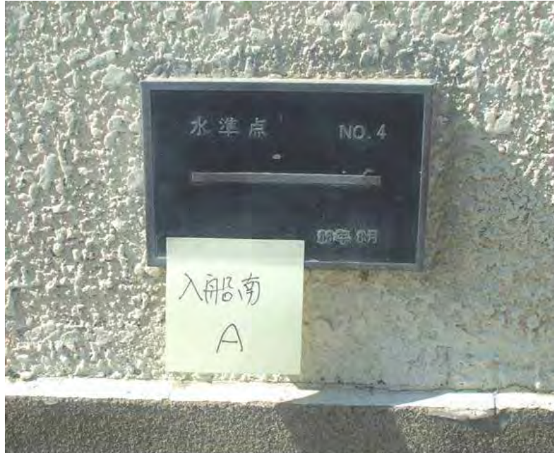
写真-1.2 校舎壁面に設置されている水準点（水準点プレート）の例
