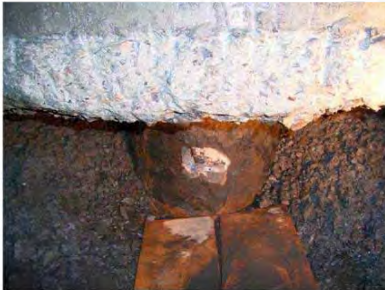
図-2.2.1 杭側面の掘削状況・杭頭部の状況（入船南小学校）
