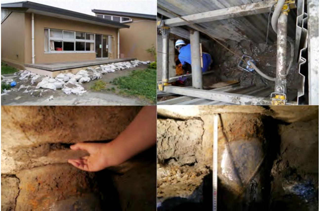
図 1.4.1-4 杭の健全性調査 2
