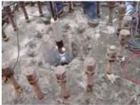
ボアホールカメラ観察状況
