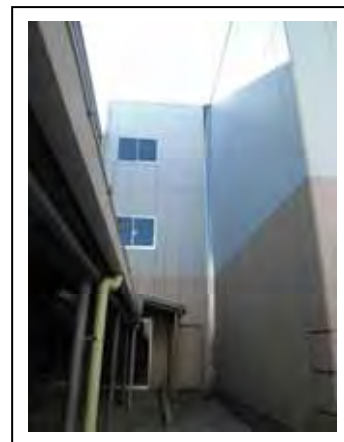
日の出中学校 エレベーター塔
