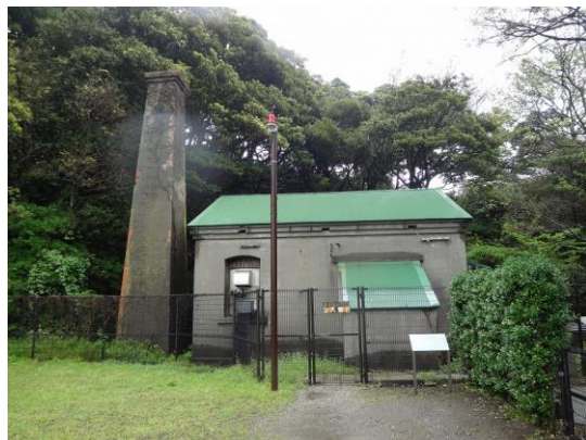
j 電気灯機関舎
