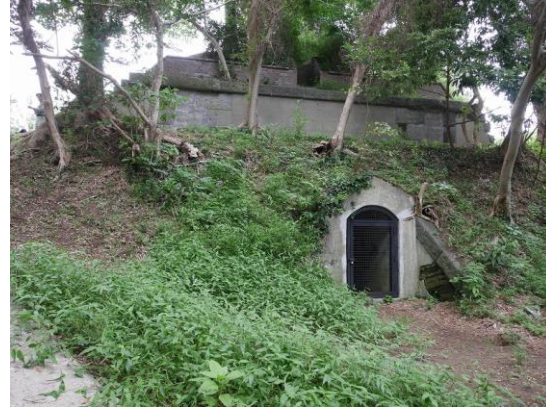
走水低砲台跡・砲側弾薬庫
