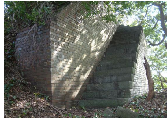
夏島砲台跡・右翼観測所通路
