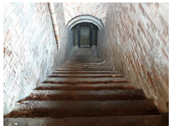
d 0 隧道から2階への階段
