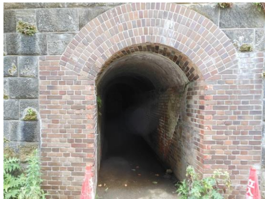
H 3 交通路出入口
