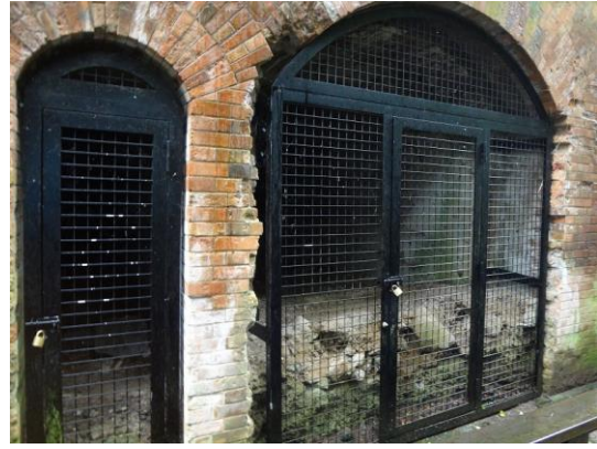
d 3 第二砲台 第二砲側弾薬庫
