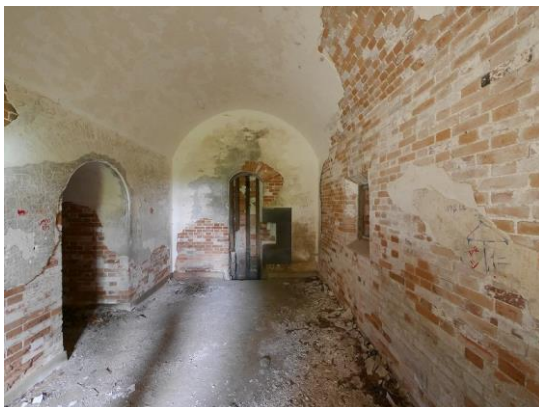
d 0 旧第一砲台 砲側弾薬庫
