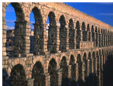
セゴビアのローマ水道橋
