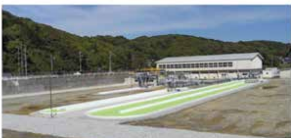
Fig. 6 熊本県天草市に建設した実証プラント
