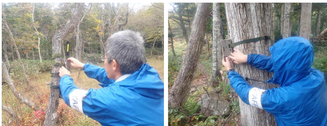
図 2-A2-5 LTE トレイルカメラ設置作業状況
