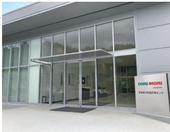
修理復旧技能研修センター
